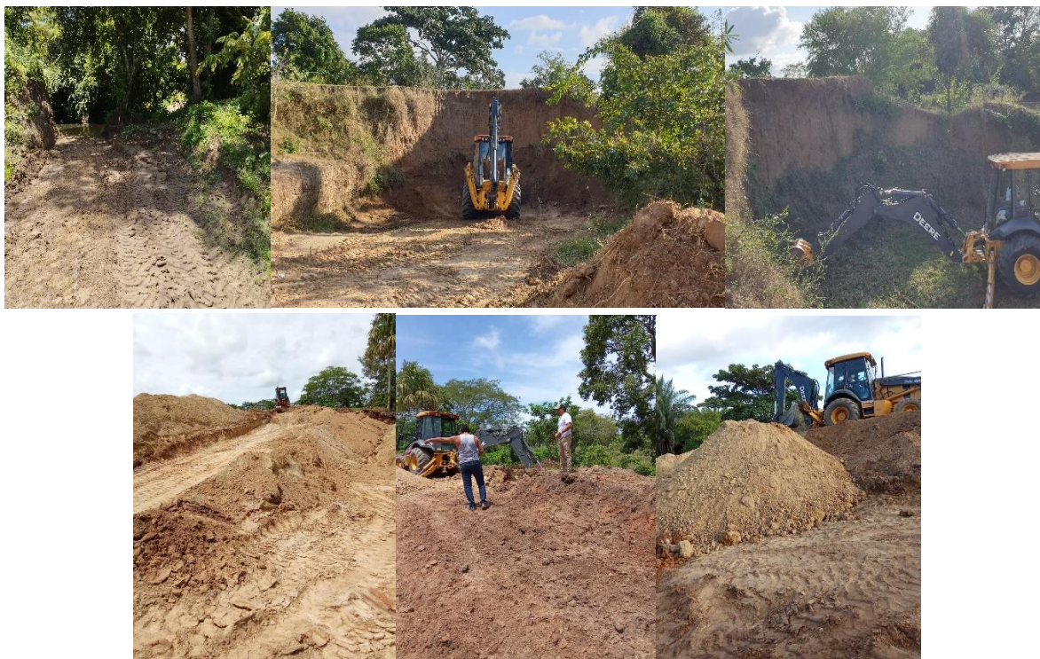
Ilustración 5. Proceso de escariación en los predios villa Vanessa y el tesoro, municipio de Morroa Fuente: CARSUCRE
