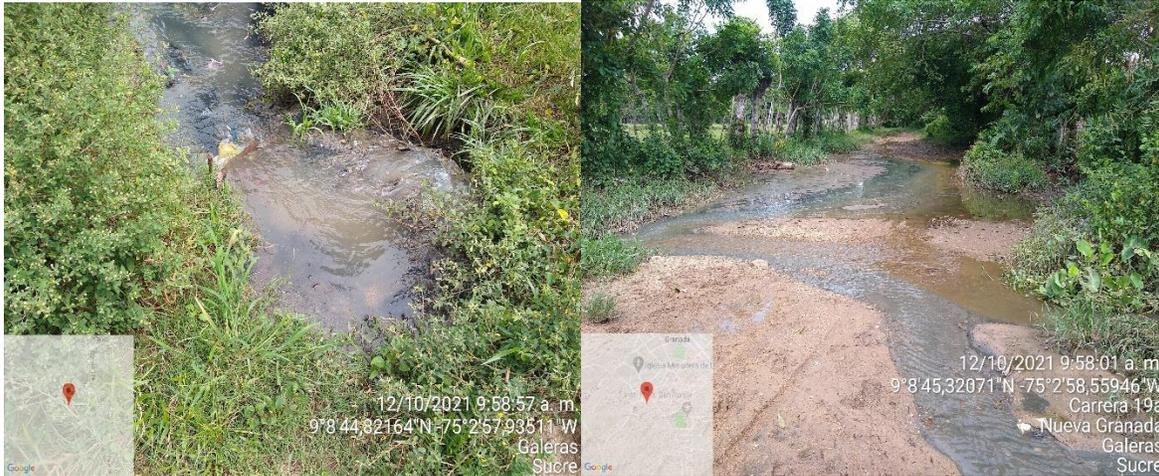
Manjón en mal estado, produciendo rebose de aguas residuales domésticas descargadas hacia entrada al STARD de Galeras. En malas condiciones.
