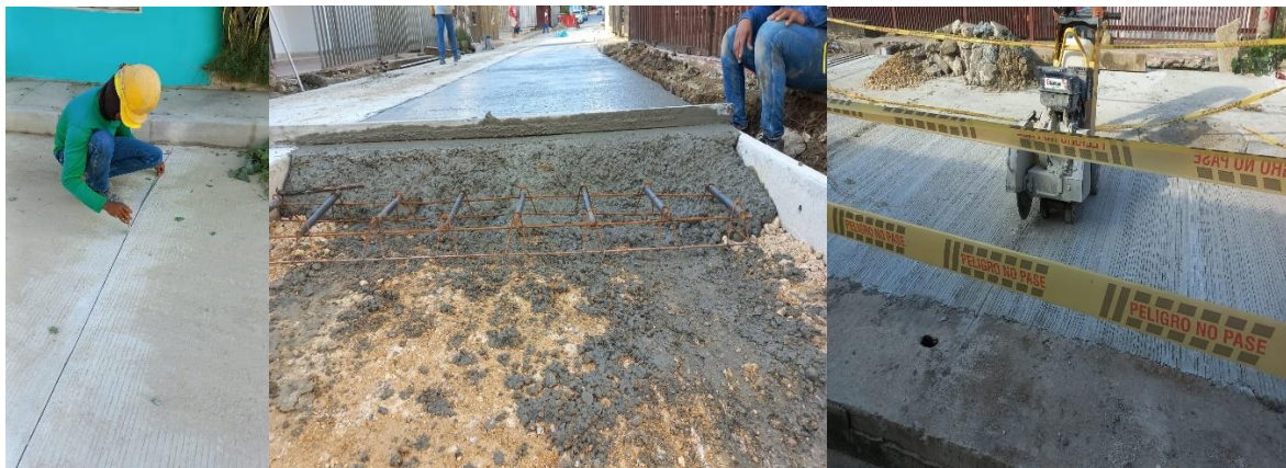
Ilustración 151. Renovación del sistema de alcantarillado y reposición del pavimento
