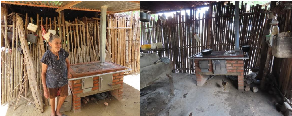
Ilustración 166. Construcción e instalación de estufas en el municipio de Betulia
