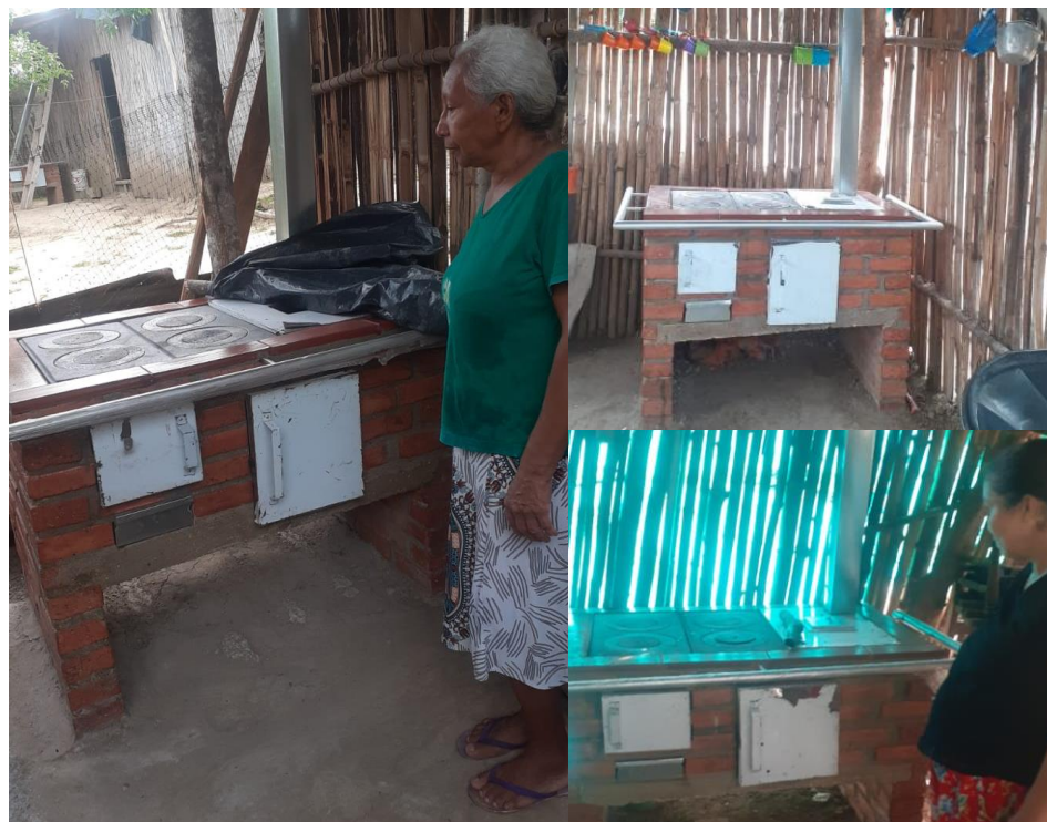
Ilustración 96. Instalación de estufas ecoeficientes
