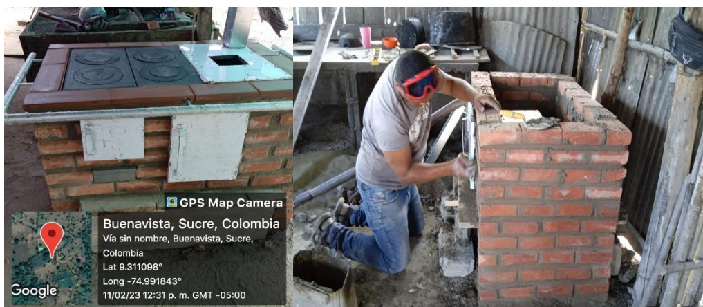
Ilustración 97. Construcción e instalación de 80 estufas de Buenavista
