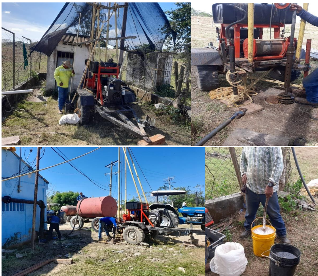
Ilustración 6. Mantenimiento a piezómetros Fuente: CARSUCRE
