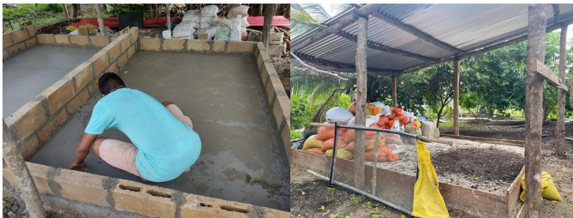
Ilustración 34. Mejoramiento de infraestructura Fuente: CARSUCRE
