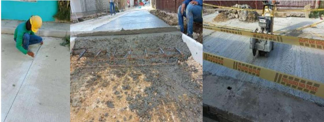
Ilustración 81. Renovación del sistema de alcantarillado y reposición del pavimento
