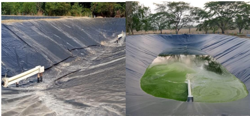
Finalización de la obra del sistema de tratamiento. Laguna de oxidación complementaria.
