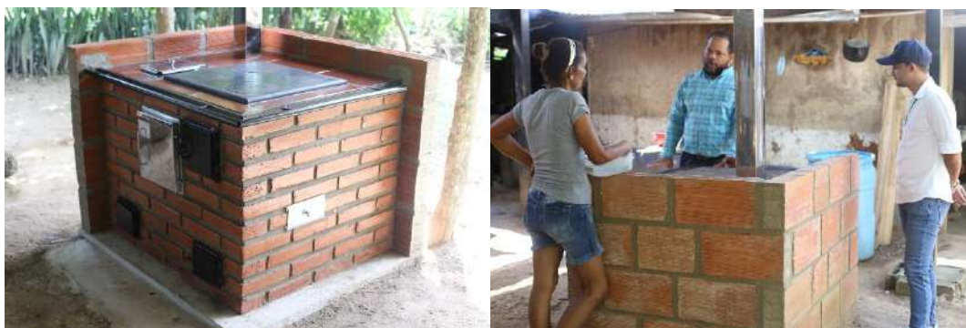
Ilustración 59. Construcción e instalación de estufas ecoeficientes
