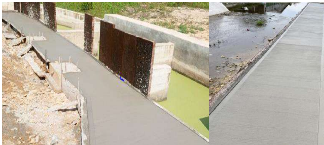
Ilustración 54. Ejecución de obra Canalización el Edén
