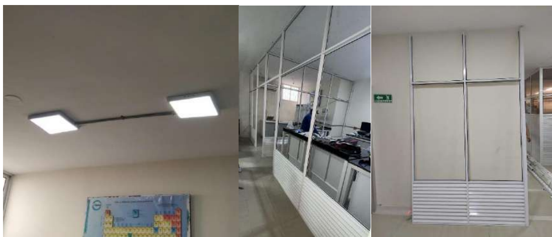
Ilustración 96. Adecuación Laboratorio Morrosquillo Fuente. Subdirección Administrativa y Financiera
