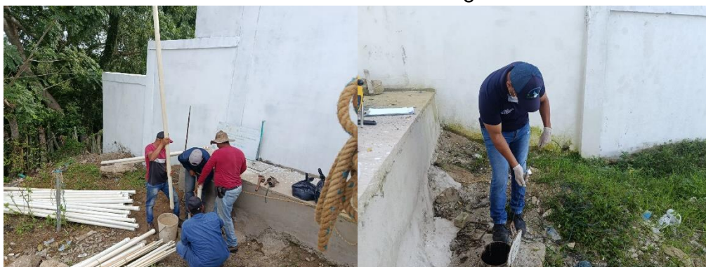
Ilustración 61. Mantenimiento piezómetro 44-IV-D-PZ-08 Fuente. Oficina de Aguas Subterráneas, 2025
