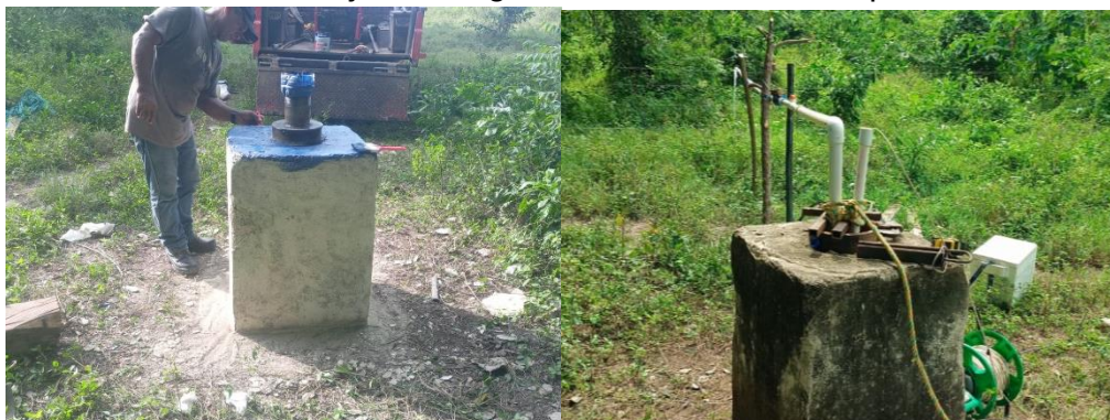
Ilustración 58. Mantenimiento piezómetro 44-I-D-PZ-24 Fuente. Oficina de Aguas Subterráneas, 2025
