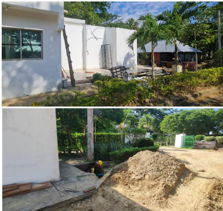
Ilustración 17. Proceso de mejoramiento de la infraestructura del CAVF ubicado en Mata de Caña Fuente. Oficina de Flora CARSUCRE, 2025
