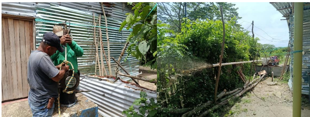
Ilustración 60. Mantenimiento piezómetro 44-IV-D-PZ-08 Fuente. Oficina de Aguas Subterráneas, 2025
