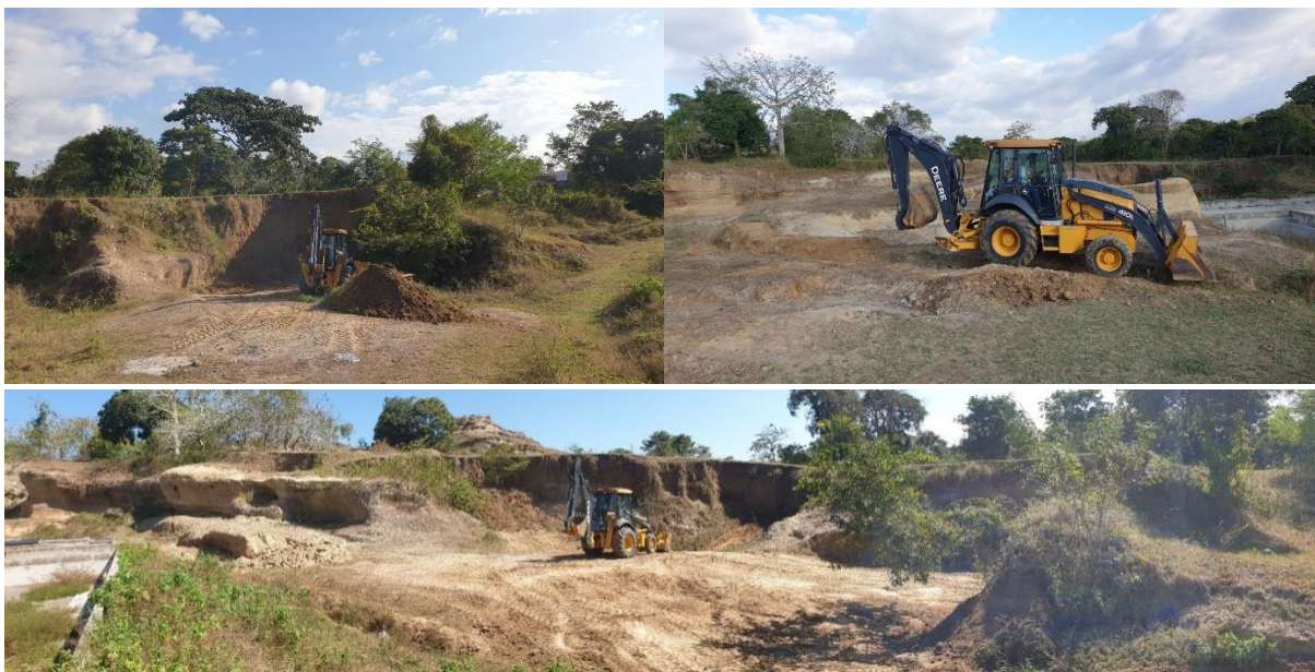
Ilustración 50. Proceso de escareación Fuente. Oficina de Aguas Subterráneas, 2025
