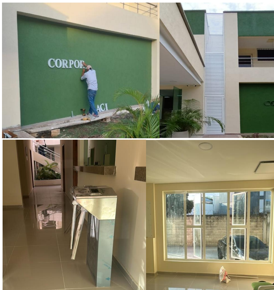
Ilustración 100. Mantenimiento y adecuaciones de la sede principal
