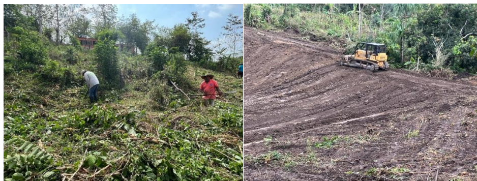
Ilustración 112. limpieza y aumento de la capacidad del Jaguey Huertas Chicas Arriba – Sampués
