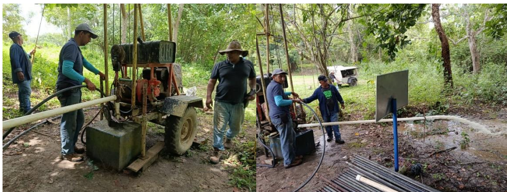
Ilustración 59. Mantenimiento piezómetro 44-IV-D-PZ-07 Fuente. Oficina de Aguas Subterráneas, 2025
