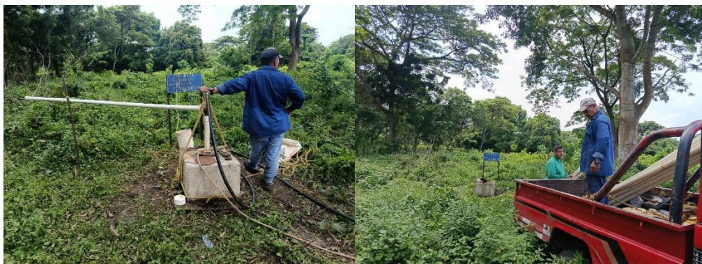
Ilustración 57. Mantenimiento piezómetro 44-I-D-PZ-23 Fuente. Oficina de Aguas Subterráneas, 2025
