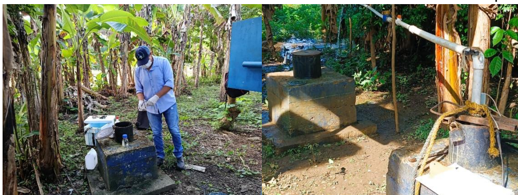
Ilustración 55. Mantenimiento piezómetro 37-III-D-PZ-01 Fuente. Oficina de Aguas Subterráneas, 2025
