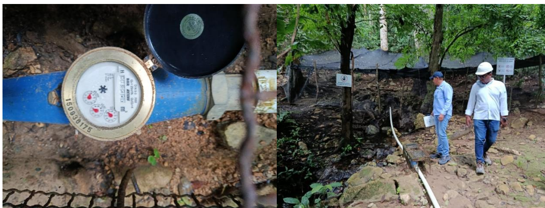
Ilustración 66. Instalación de cerramiento perimetral e instalación de medidor de agua para el control de consumos
