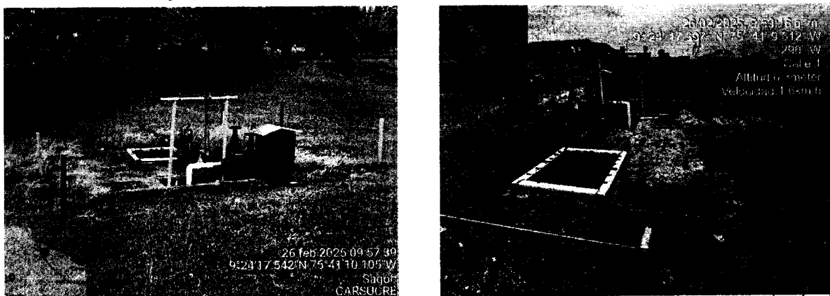
Ilustración 13. Estación elevadora de aguas residuales N°1.
