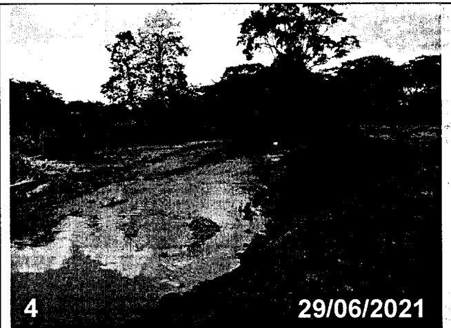
Imagen No. 4. Vista del tramo intervenido de la margen derecha del arroyo Pechelin.
