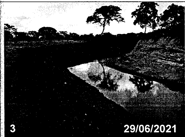
Imagen No. 3. Vista del tramo intervenido de la margen derecha del arroyo Pechelin.
