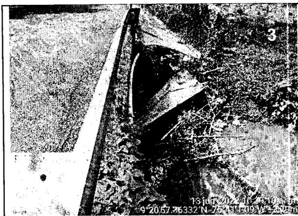
**Imágenes No. 3.** Margen derecho del box culvert, se evidencia aleta del box culvert desplomada sobre el cauce del arroyo La Ceiba, cerca perimetral sobre el cauce del arroyo.
