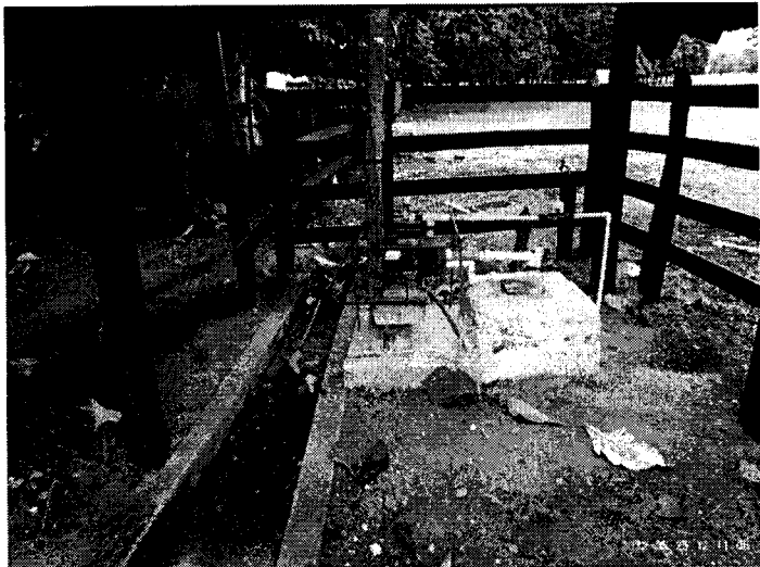
Foto 1. Pozo 44-I-D-PP-150 con su equipo de bombeo
