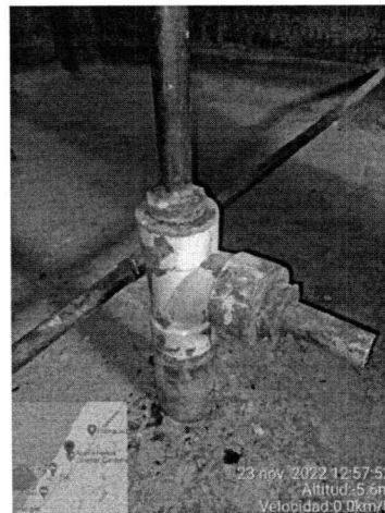
Figuras 3, 4 y 5. Pozo con código 43-IV-A-PP-383, detalle de macromedidor y su ubicación.
