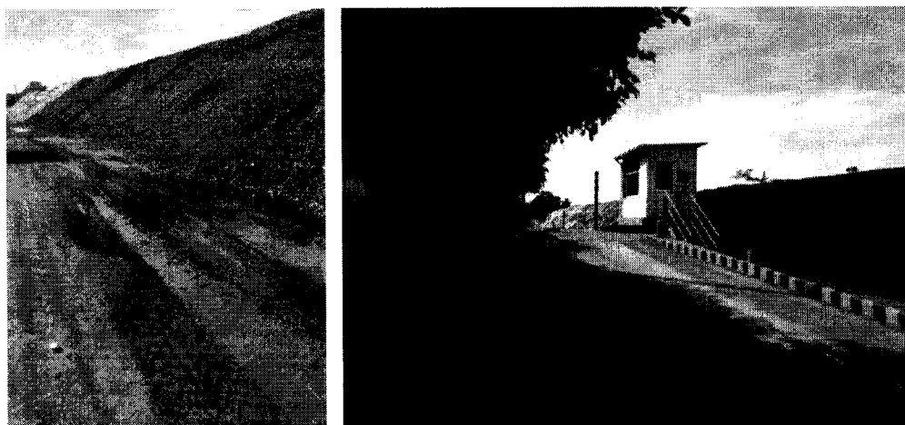
Figura 13 y 14. Evidencias fotográficas del área de interés. Acopio de carbón descubierta y caseta de vigilancia.
