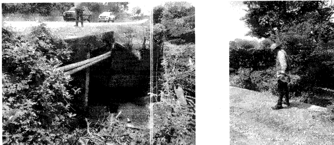
Figura 3. Abscisa K0+950 de la vía Guayabal – Parcelas de Algarrobo, box culvert doble con sección rectangular de 2,5 m de ancho por 1,5 m de alto.
