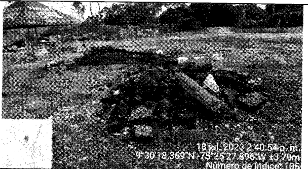
Imagen 11: Vista de residuos de construcción y demolición sujetos aprovechamiento para las adecuaciones de la zona del proyecto
