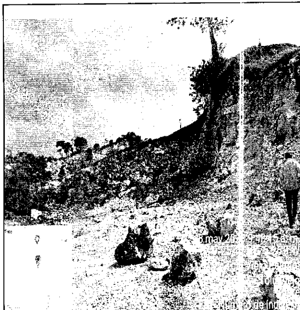
3. Frente de explotación localizado en la coordenada E:851098 - N: 1537420 en el cual se evidencia fragmentación de roca caliza producto de la extracción artesanal realizada en la zona.
