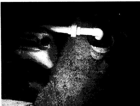
Foto No 1 y 2: Pozo construido en tubería de 6" en RDE 26 con 2 llaves de control a la salida.
