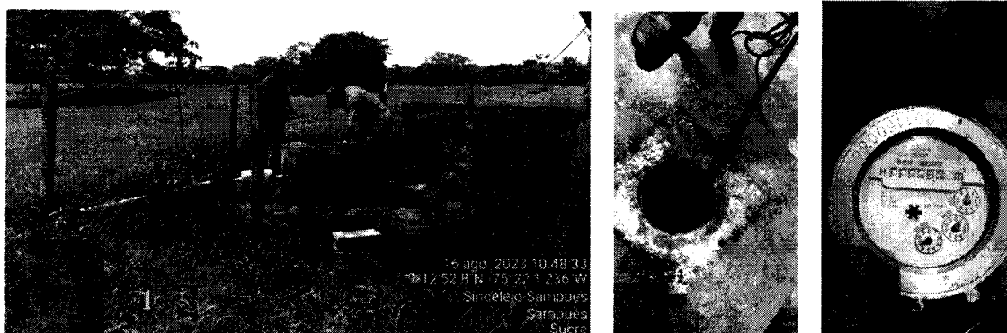
Fotos 1, 2 y 3. Equipos del sistema de bombeo del Pozo No. 52-II-A-PP-24.
