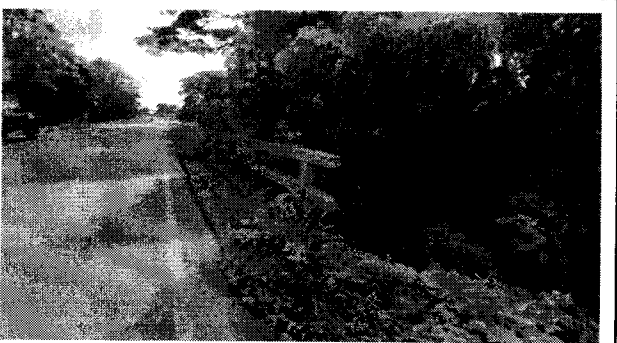
Imagen 6. K4+582. Se evidencia cobertura vegetal en condiciones aceptables. Ay. Palmar. Fuente: Consorcio Vías y Equipo 2020
