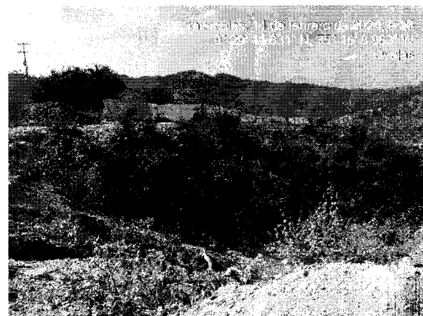
Figura 6. Zona de Depósito de Materiales de Excavaciones y Demoliciones sin ningún tipo de intervención con crecimiento de cobertura vegetal.
