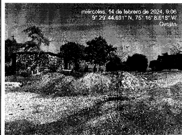
Figura 11. Almacenamiento de residuos aprovechables tipo recebo provenientes de excavaciones por fuera del área del ZODME
