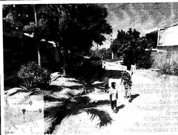
Imagen 1. Evidencia del Inicio de la obra . Fuente: Equipo Técnico CARSUCRE.
