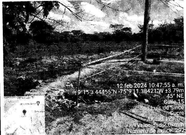
Imagen 4. Medida Preventiva de cerramiento, con el objeto de prevenir el paso de los habitantes del sitio. Fuente: equipo técnico CARSUCRE
