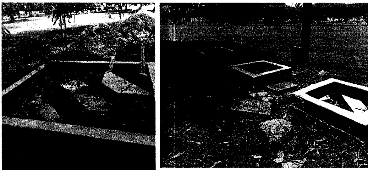
Figura 2 y 3. Sistema de tratamiento de aguas residuales domesticas de Oleoducto de Colombia S.A.
