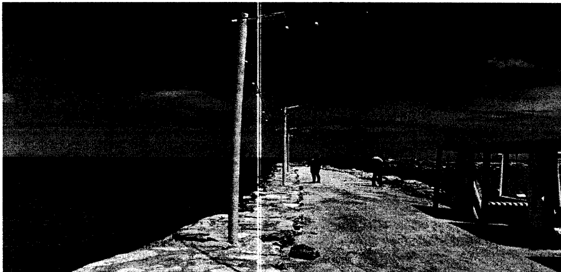
Figura 4. Presencia de espolón en I intervenido.
